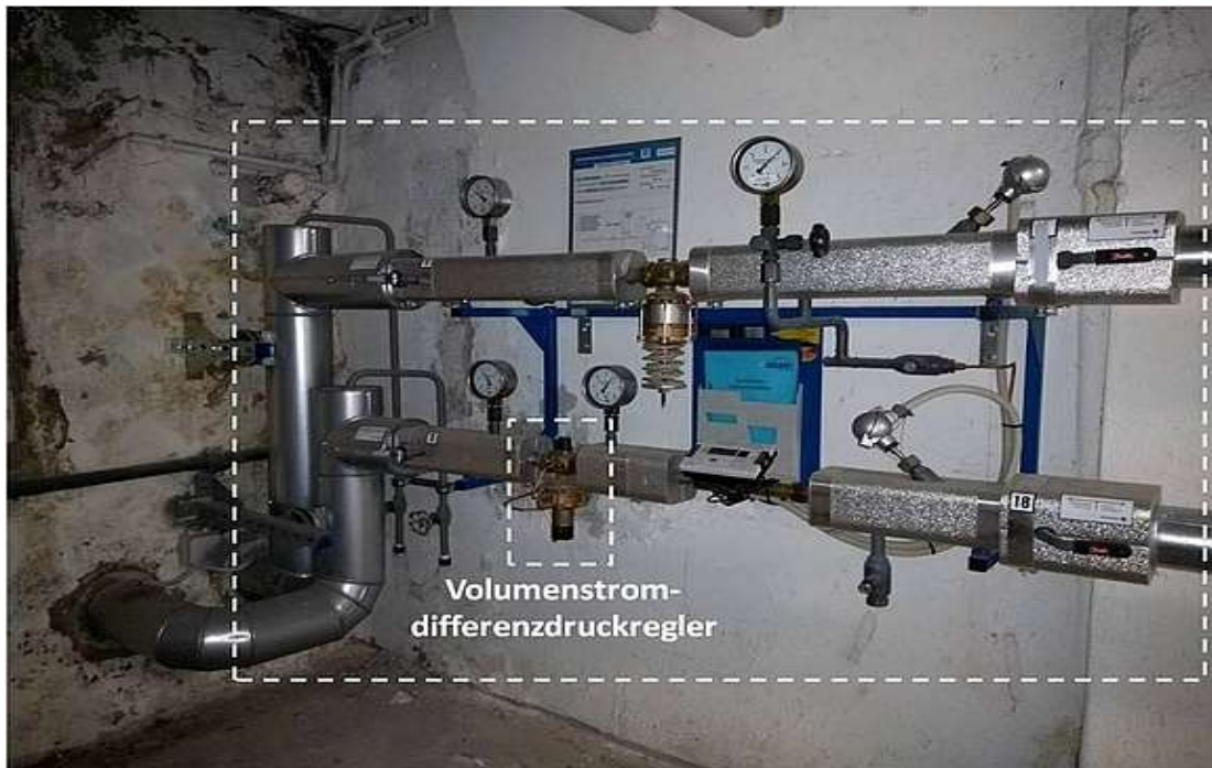
Fotografia 6. Model stație de transfer energie termică
