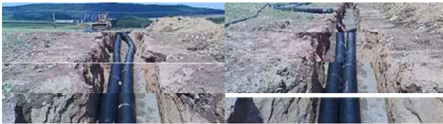
Fotografia 17. Modele de pozare conductă
