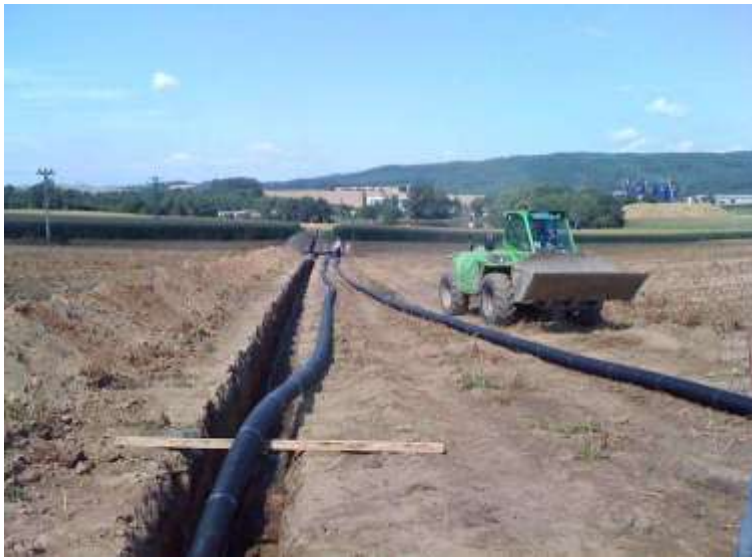
Fotografia 16. Model de pozare conductă
